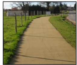
Sablé stabilisé renforcé
