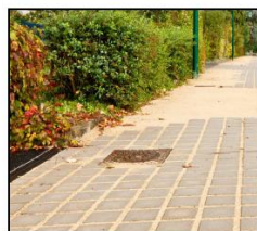
Pavé bétons avec joints sablés
