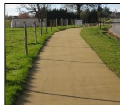
Sablé stabilisé renforcé
